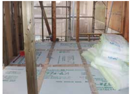
床板を撤去し、床下に断熱材を施工 (画像提供: エコワークス)
